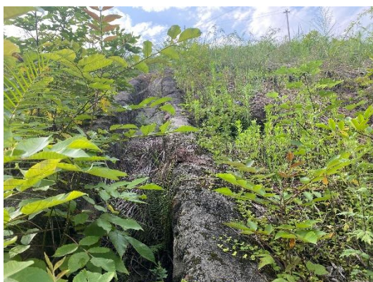
8#弃渣场排水沟
