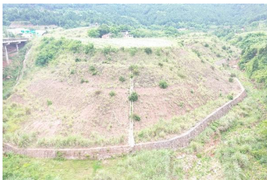
2#弃渣场挡渣墙及排水沟
