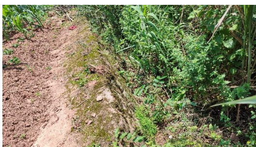
11#弃渣场挡渣墙
