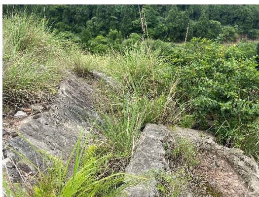
2#弃渣场马道挡墙及排水
