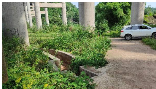
15#弃渣场沉砂池
