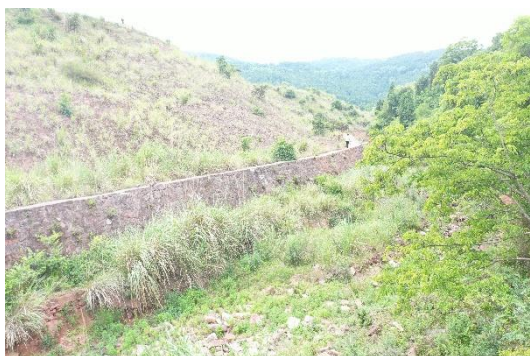
2#弃渣场挡渣墙
