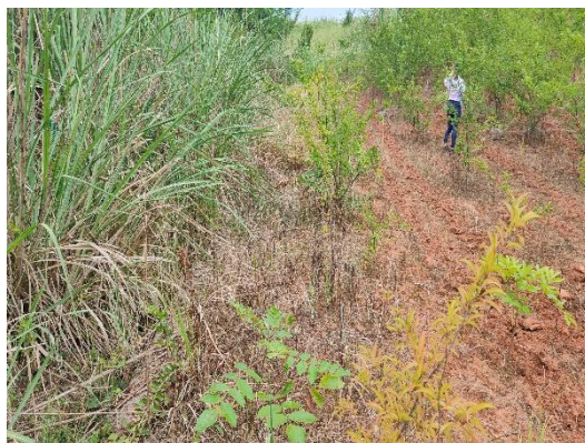
3#弃渣场排水沟
