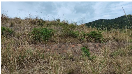
1#弃渣场挡渣墙
