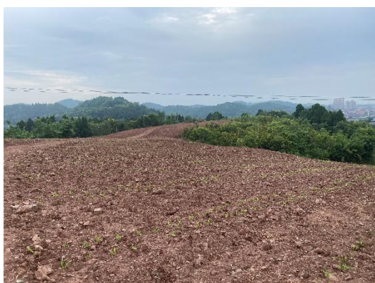
7#弃渣场渣顶现状 1
