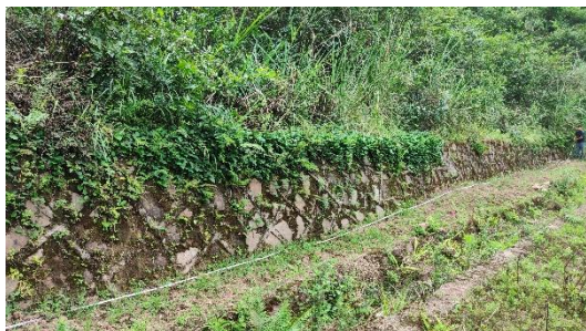
21#弃渣场挡渣墙测量
