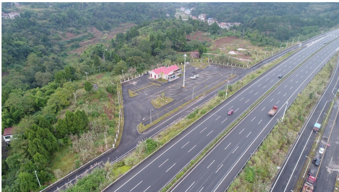
服务区建设现状
