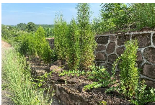
15#弃渣场挡渣墙及排水沟
