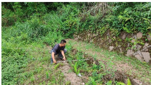
21#弃渣场挡墙及排水沟
