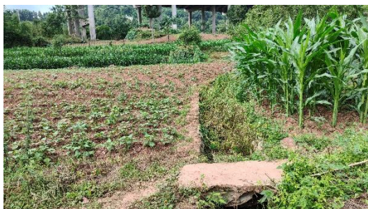
20#弃渣场排水沟
