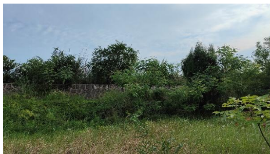
19#弃渣场挡渣墙 2
