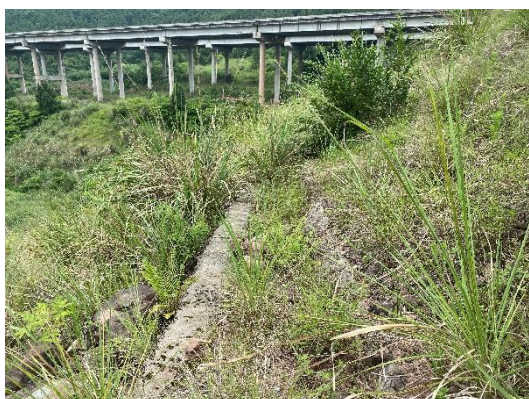
2#弃渣场马道排水沟
