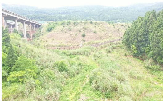
2#弃渣场挡渣墙及排水沟
