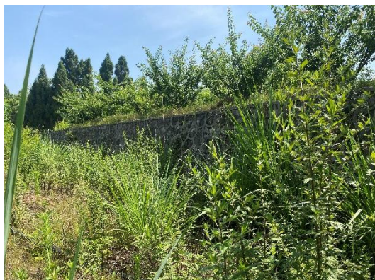
13#弃渣场挡渣墙
