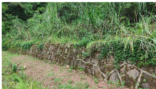
21#弃渣场挡渣墙
