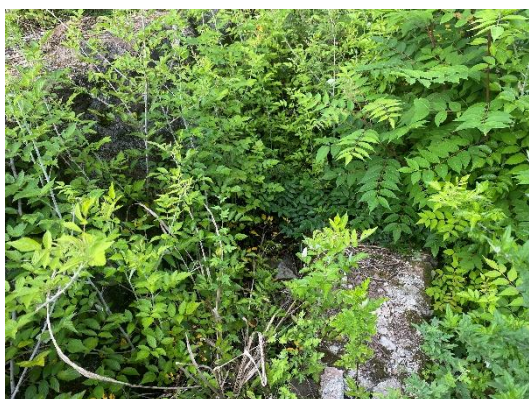
8#弃渣场挡渣墙 1
