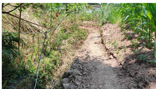
11#弃渣场排水沟
