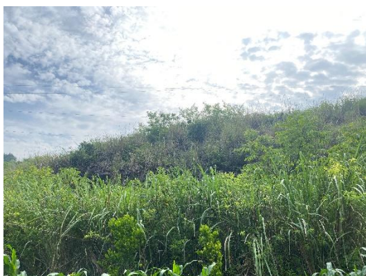
6#弃渣场干砌石边坡 1
