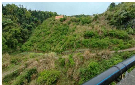
21#弃渣场挡墙及边坡
