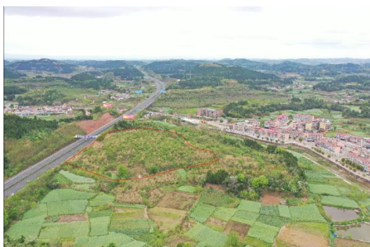
7#弃渣场航拍图 1 (复耕前)
