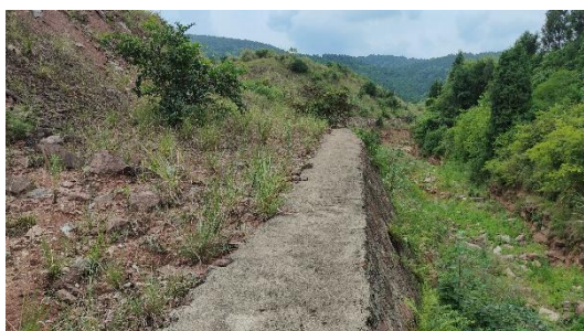
2#弃渣场渣底挡渣墙
