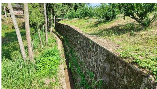
14#弃渣场挡渣墙及排水沟
