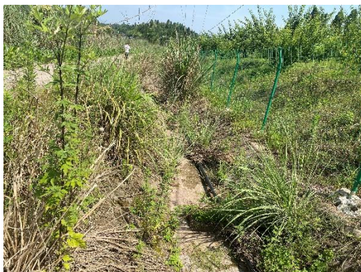
13#弃渣场排水沟
