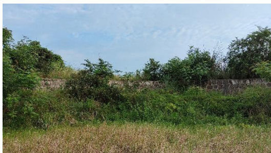
19#弃渣场挡渣墙 1
