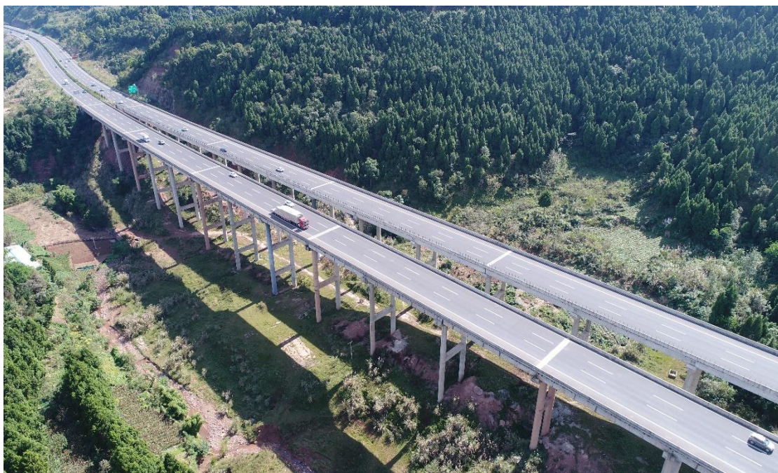
桥梁建设现状
