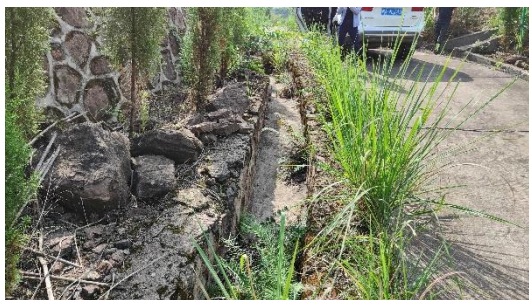
15#弃渣场排水沟
