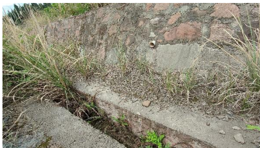
1#弃渣场排水沟
