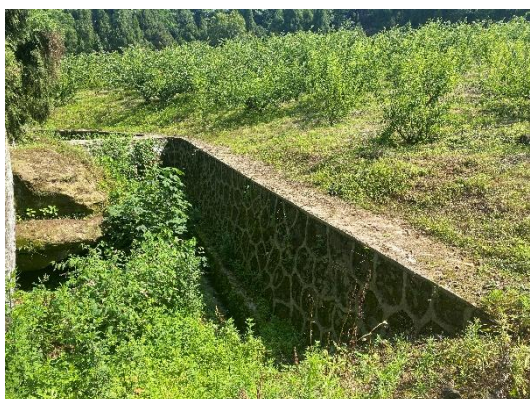
14#弃渣场挡渣墙
