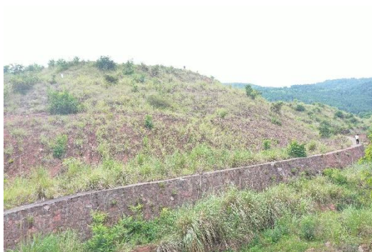
2#弃渣场挡渣墙
