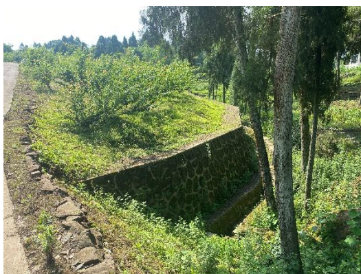
14#弃渣场挡渣墙及排水沟
