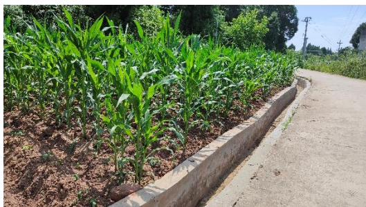
渣场排水沟（临道路侧）
