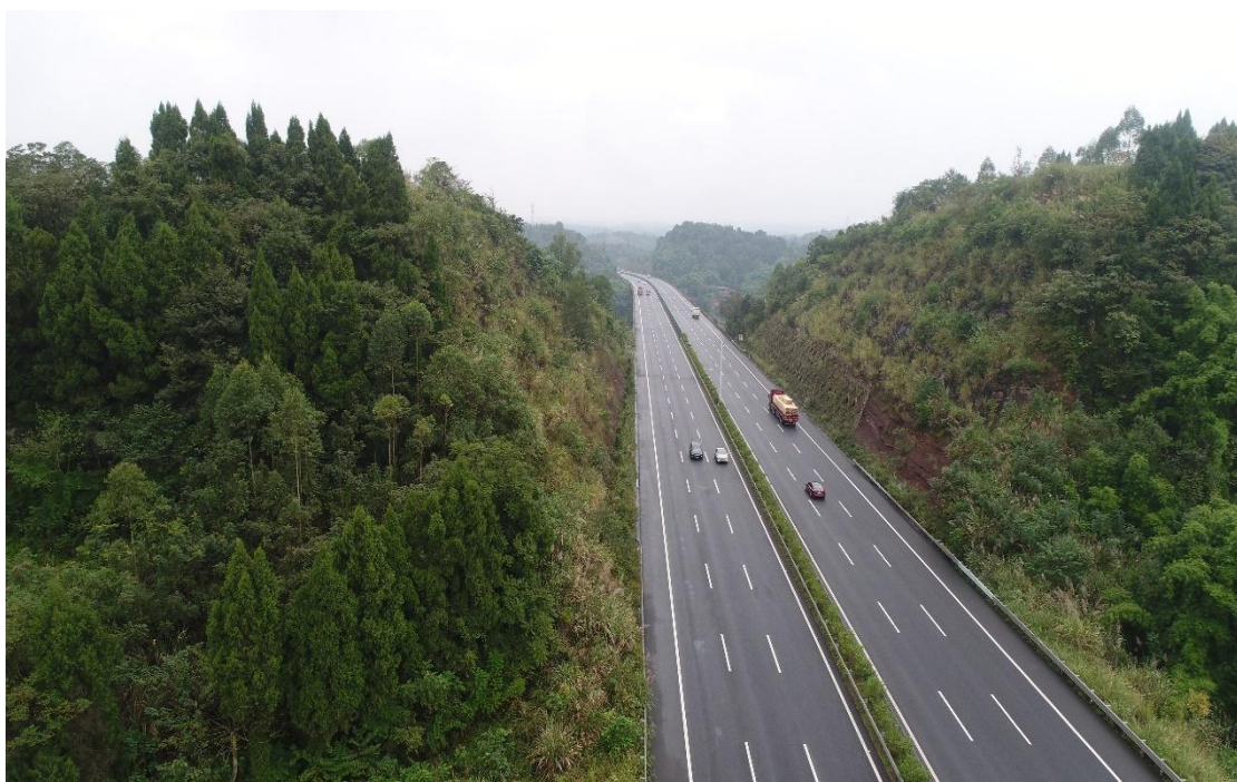
路基边坡防护情况
